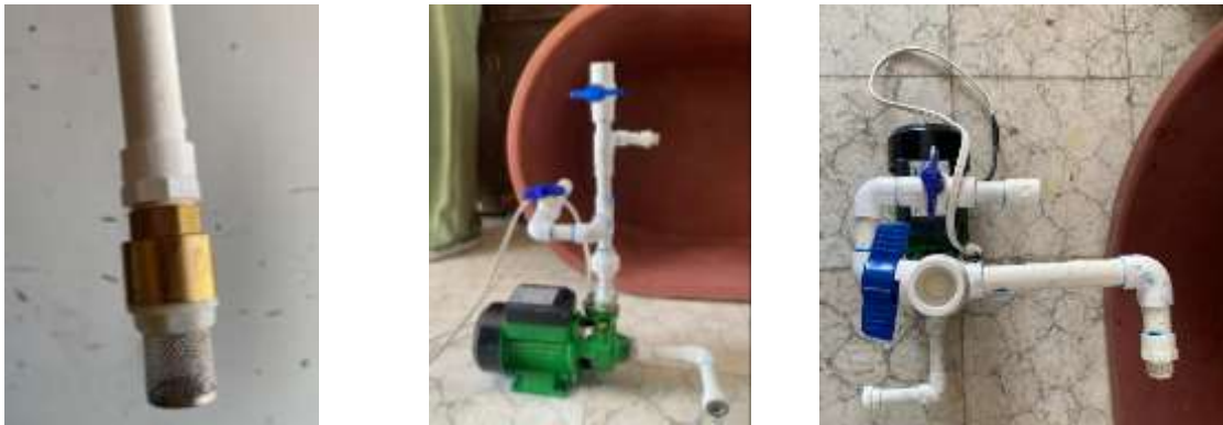
Figura 2. Componentes para el bombeo de agua: a) pichanca, b) bomba de presión, c) entrada y salida de agua hacia la bomba
